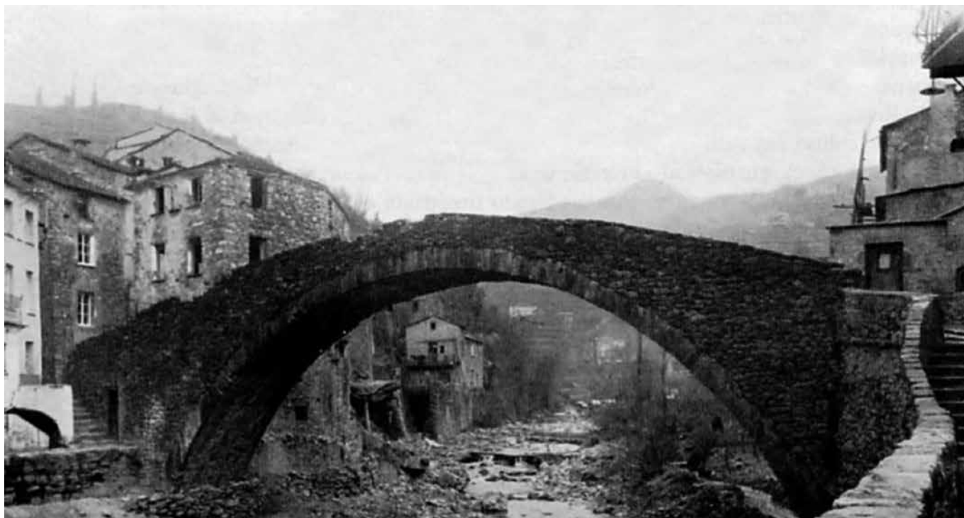
Fig. 2. Ponte di Grexino, a Varese Ligure (foto di Zancolli in Merlo C., Liguria, Collana "Le regioni d'Italia", Torino, UTET, 1961).
