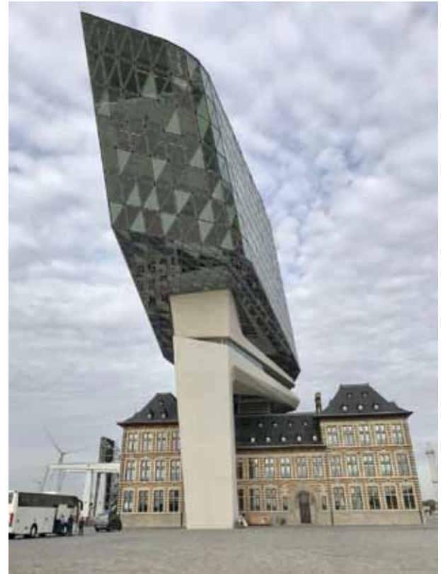
Fig. 5. Porto di Anversa - ulteriore dettaglio del nuovo centro direzionale “Port House”, in un’opera a forma di diamante. Impostato dall’ingegnere belga Guy Mouton, si basa sulla realizzazione di due pilastri di cemento giganti che sostengono interamente la nuova costruzione sovrapposta alla struttura preesistente. La complessa struttura metallica prefabbricata di copertura è composta di travi reticolari saldate e assemblate sul posto al momento della realizzazione. In modo ingegnoso, la nuova struttura non tocca quasi da nessuna parte quella vecchia, e l’unico punto d’incontro risulta costituito da un pozzo di vetro di connessione che attraversa la torre della vecchia stazione dei vigili del fuoco e proietta i visitatori nel ventre dell’edificio. (Foto a cura dell’autore).
