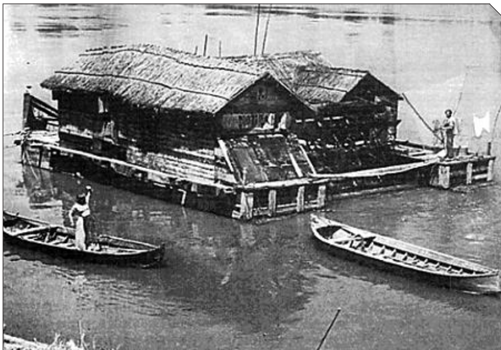
Fig. 2 - Mulino galleggiante ricostruito per il film "Il Mulino del Po" di Alberto Lattuada (1949). Le due costruzioni in legno affiancate, con tetto di stuoie e di canne, ospitavano una la macina per il frumento e l'altra quella per il granturco.
