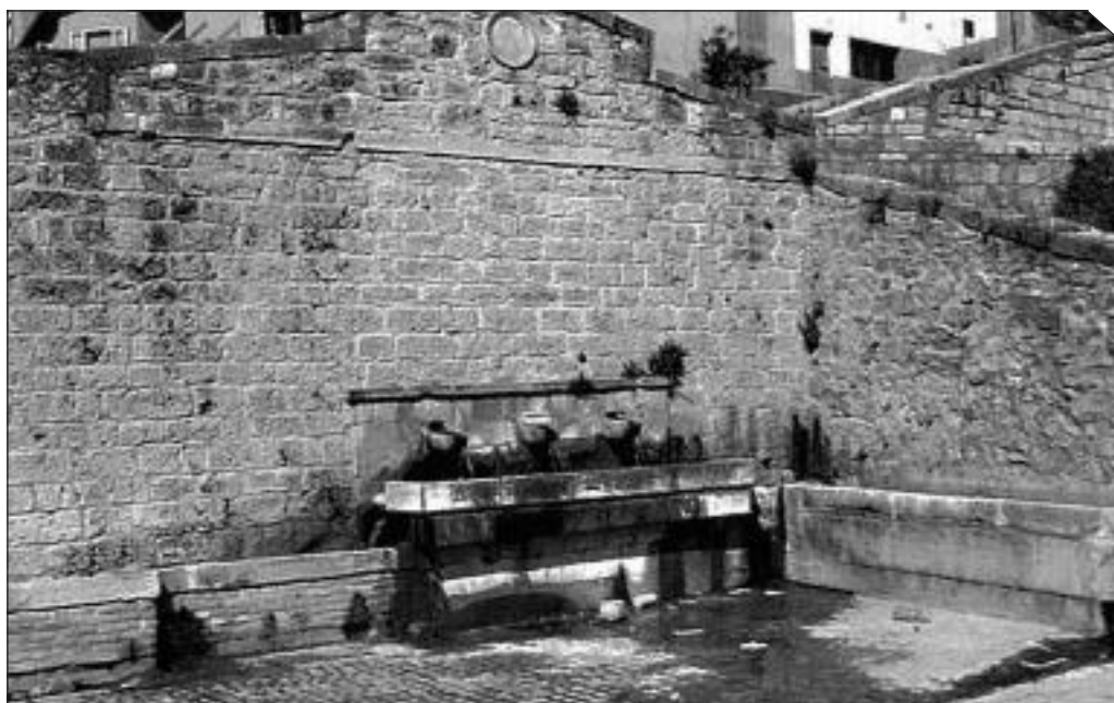
Castelmauro, la Fonte Condotta.
