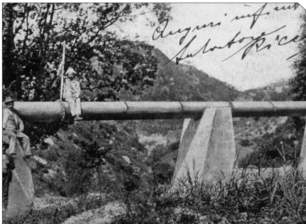
Agnone, la condotta forzata dell'impianto idroelettrico del Verrino.
