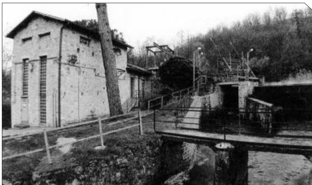
Lucito, la centrale Precettoressa vista dal canale di scarico.
