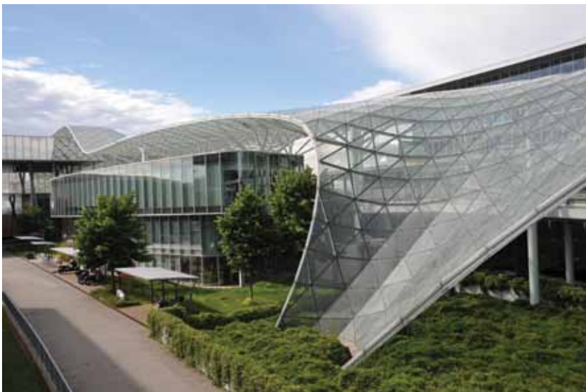
Fig. 6. Particolare della "vele", struttura di vetro e acciaio lunga circa 1,5 km e alta fino a 37 m, che si sviluppa lungo l'asse centrale della fiera di Rho-Pero. Foto Flora Pagetti, 2013.
