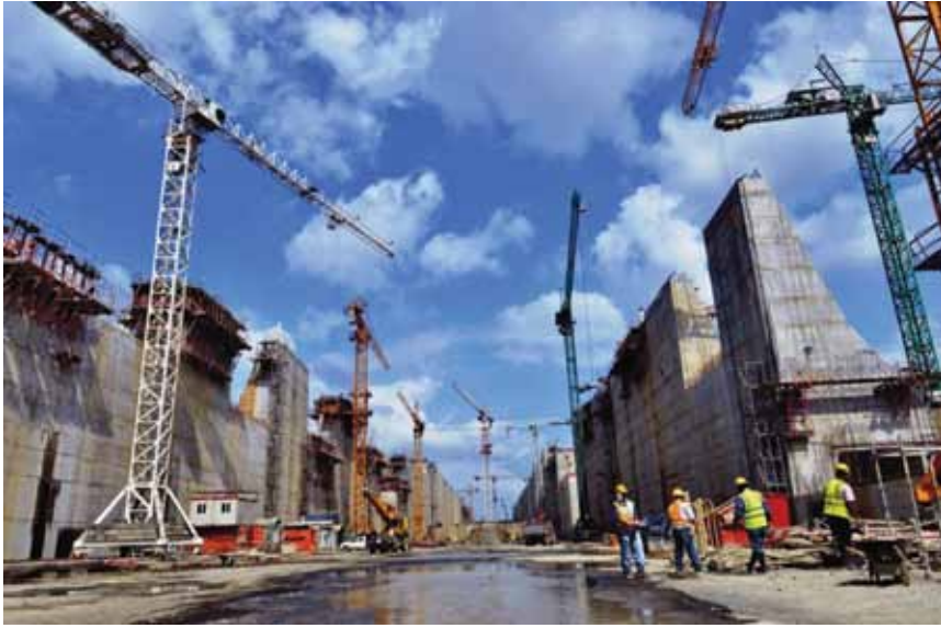
Fig. 3. Milioni di mc di cemento sono stati impiegati per innalzare paratie equivalenti all'altezza di un palazzo di cinque piani.
