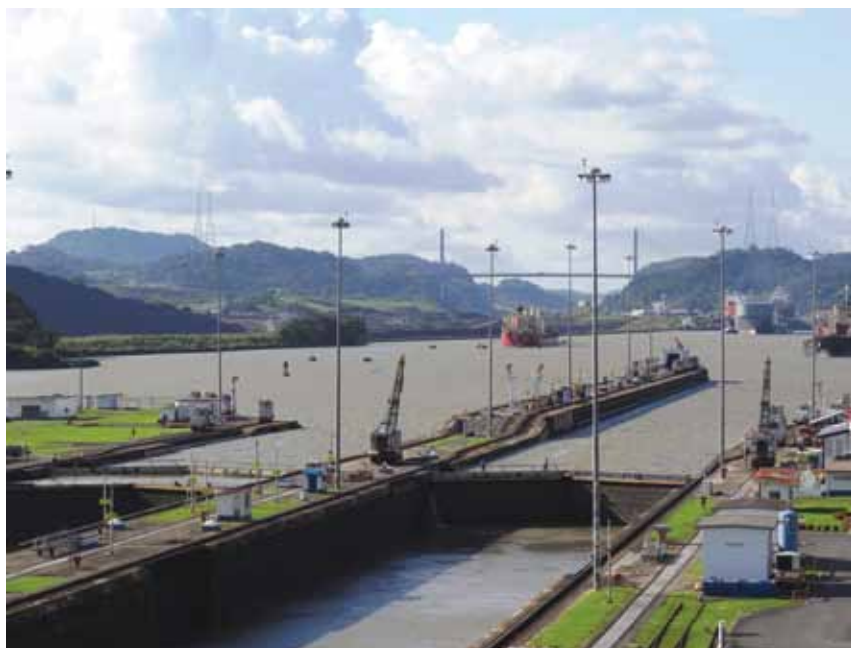
Fig. 5. Chiusure di Miraflores. Sullo sfondo il ponte del Centenario costruito nel 2004. È evidente il dislivello tra l'interno e l'esterno della chiusa.
