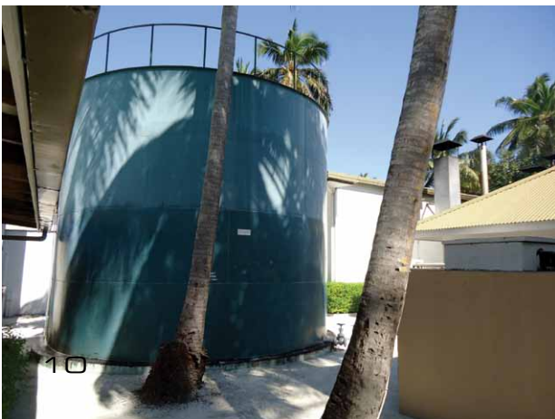
Fig. 4. Serbatoio d'acqua al resort Velavaru (Foto dell'autore).
