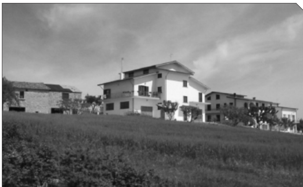
Foto 2 - La foto mostra il contrasto che si viene a creare con un'edilizia non regolamentata da idonei strumenti urbanistici.
