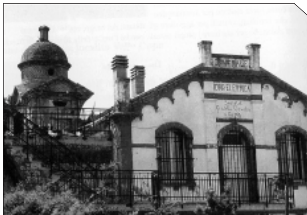
Limosano, centrale idroelettrica Fratelli Covatta & C.
