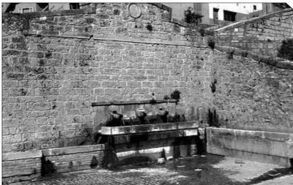
Castelmauro, la Fonte Condotta.
